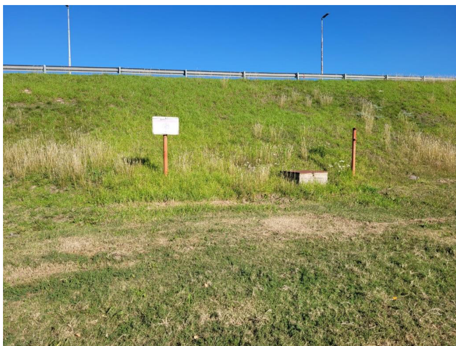
Imagen 7. Mojonamiento y cartelería actual del tramo de poliducto a abandonar.
